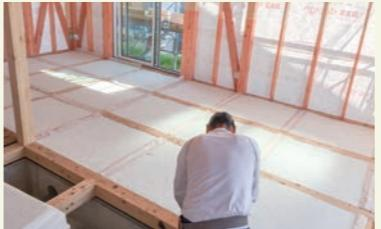
隙間なく断熱施工を可能にする床用の高性能グラスウールを採用。透湿性があり床合板の湿気を逃がします。
