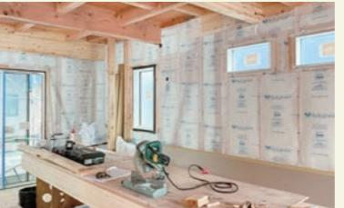
壁には 105mm 厚の高性能グラスウールを敷き詰めています。高い防湿性能も併せ持つており、湿気の侵入を防ぎます。
